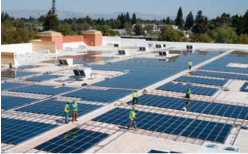
Walmart, Kaliforniya ve Arizona'daki 30 mağazasının çatısını ince film güneş panelleriyle kaplama çalışmalarını sürdürüyor.
