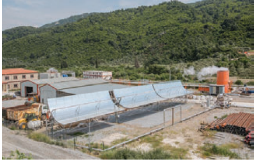
GeoSolar Projesi ile 155 derecedeki jeotermal su kaynağı, güneş enerjisinden yararlanılarak 165 dereceye çıkarılıyor.
