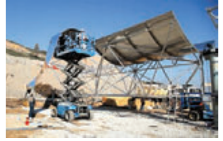
GeoSolar Projesi ile 155 derecedeki jeotermal su kaynağı, güneş enerjisinden yararlanılarak 165 dereceye çıkarılıyor.
